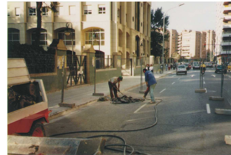
DEMOLICIÓN MANUAL LOCALIZACIÓN DE SERVICIOS
