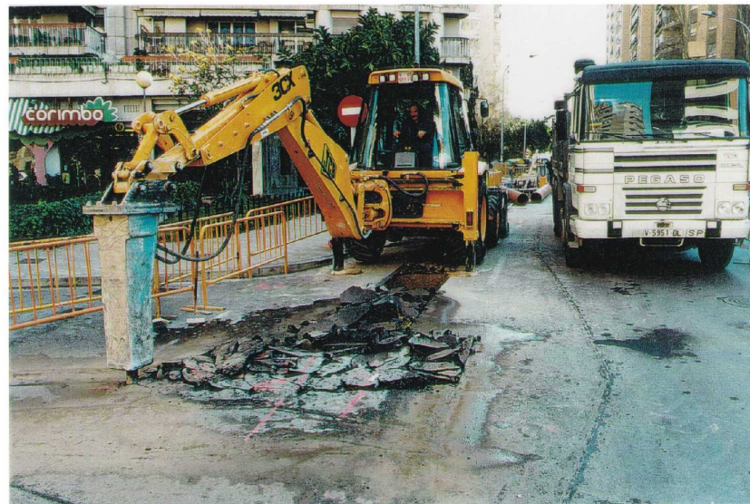
DEMOLICIÓN MECANICA DE PAVIMENTO ASFALTICO
