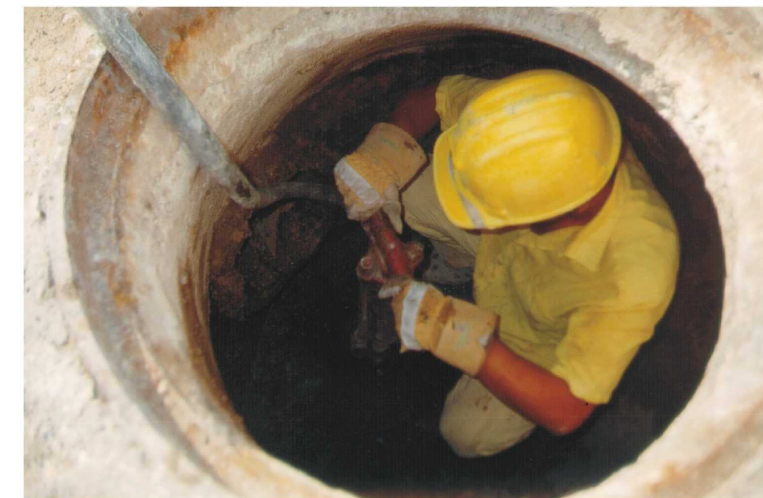
DEMOLICIÓN MANUAL EN INTERIOR DE POZO
